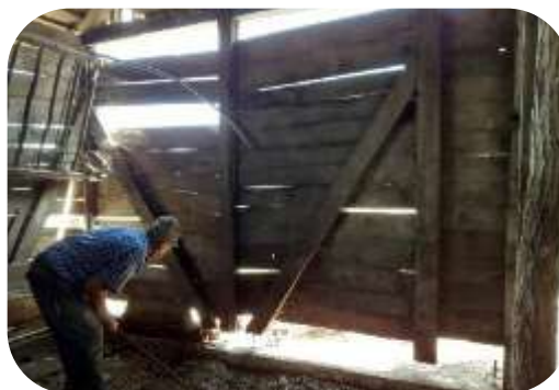
Štala – betoniranje, popravak strunulih podsjeka BED
